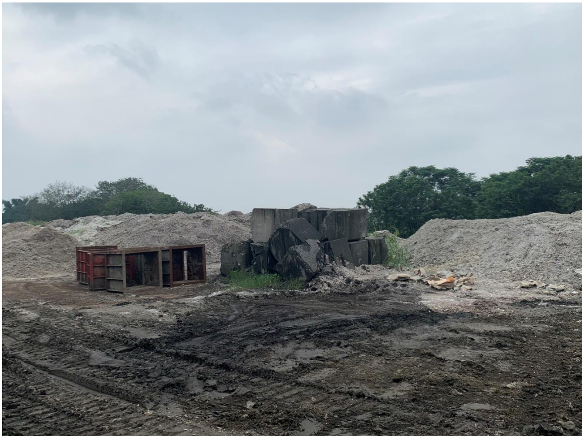
照片說明：現場遭堆置之廢棄混凝土塊及混合事業廢棄物
