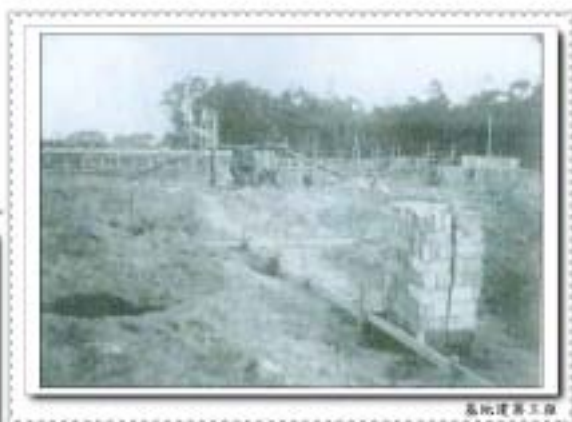
基礎建築工程
