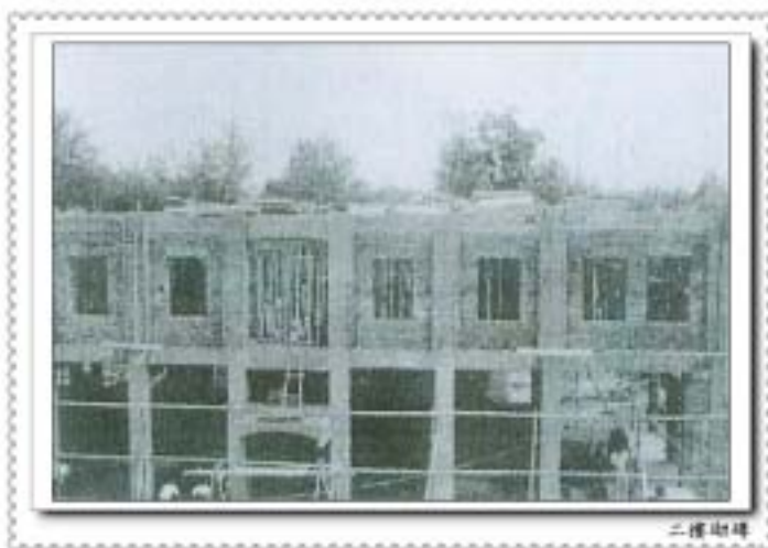
一度拆除橫板後
