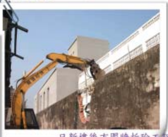
日新樓後方圍牆拆除工程
