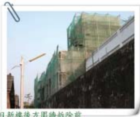
日新樓後方圍牆拆除前
