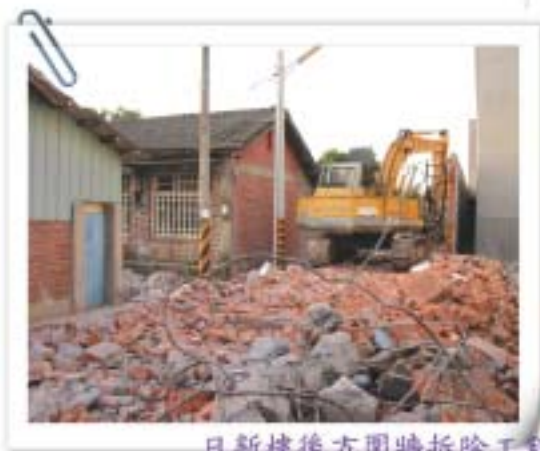
日新樓後方圍牆拆除工程
