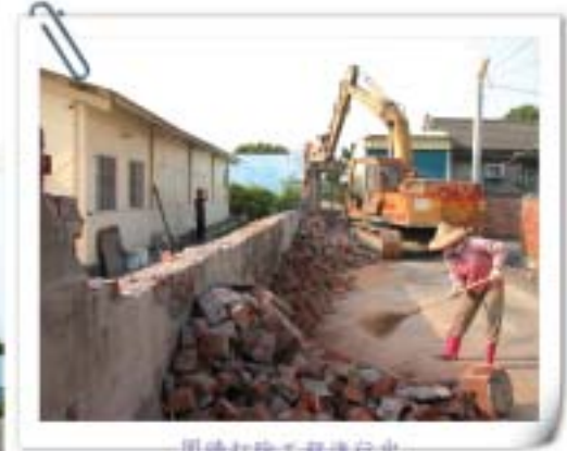
圍牆拆除工程進行中
