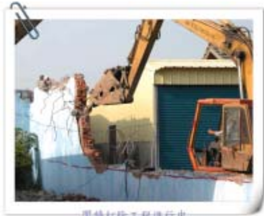
圍牆拆除工程進行中
