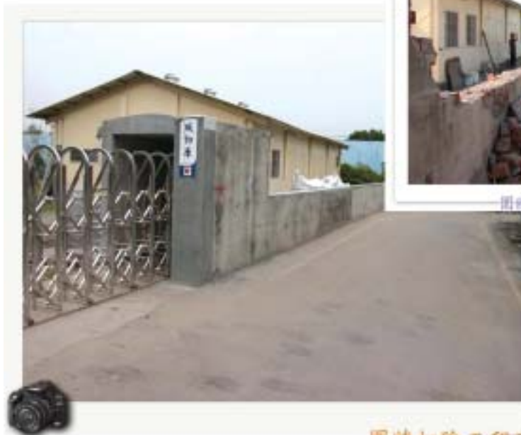
圍牆拆除工程完工
