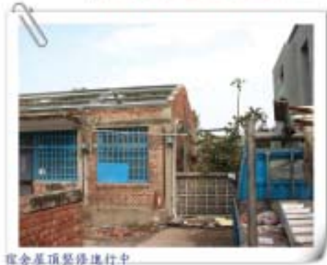
宿舍屋頂整修進行中
